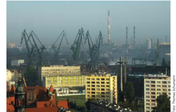
Die toten Arme der Verladekräne rosten vor sich hin, Lagerhallen verfallen, Industriewege und Brücken enden im Nichts. Die Danziger Werft heute.
